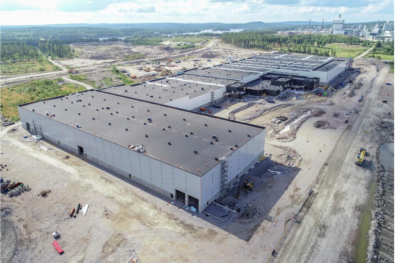
LapWallin puukattoelementit Metsä Woodin Äänekosken uudessa Kerto-LVL-tehtaassa. (kuva Metsä Group)
